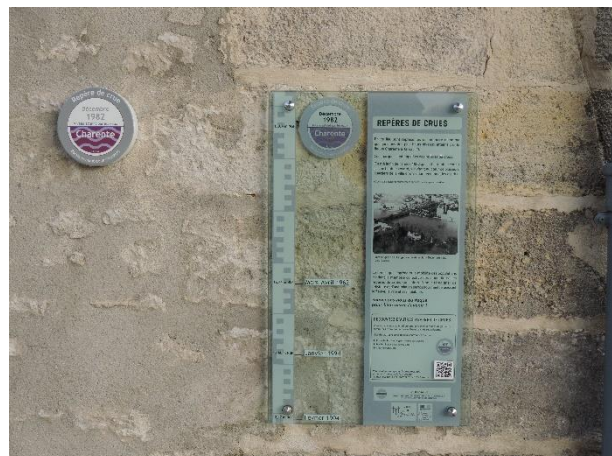
FIGURE 36 : REPERE DE CRUE ET PLAQUE D'INFORMATION INSTALLEES A JARNAC (16) DANS LE CADRE DU PAPI CHARENTE & ESTUAIRE
