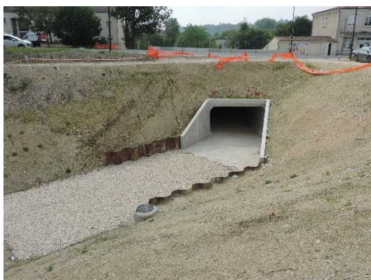
FIGURE 57 : OUVRAGE DE DECHARGE DE L'ANGUIENNE A ANGOULEME
