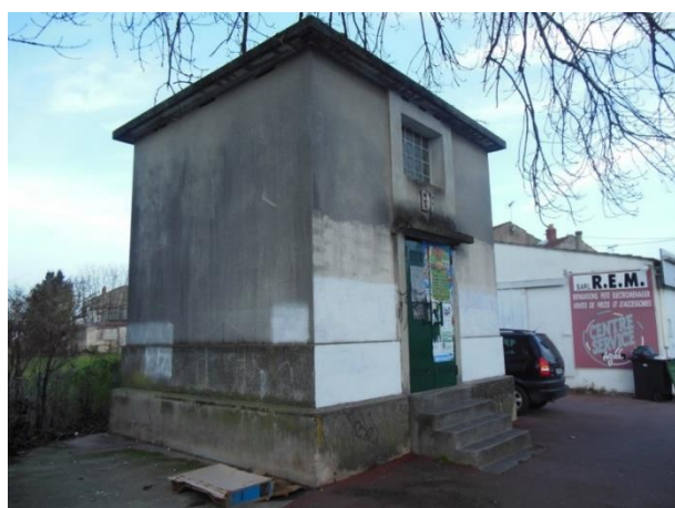
FIGURE 24 : TRANSFORMATEUR HORS SOL
