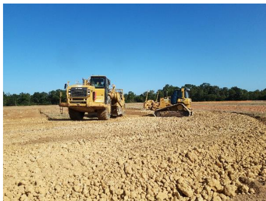
FIGURE 52 : TERRASSEMENT DES DIGUES DES LAGUNES DE DECANTATION - AOUT 2019
