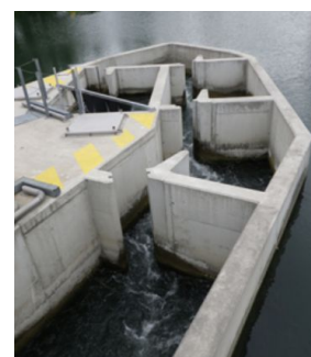
Barrage de Crouin (passe à poissons & station de comptage)
