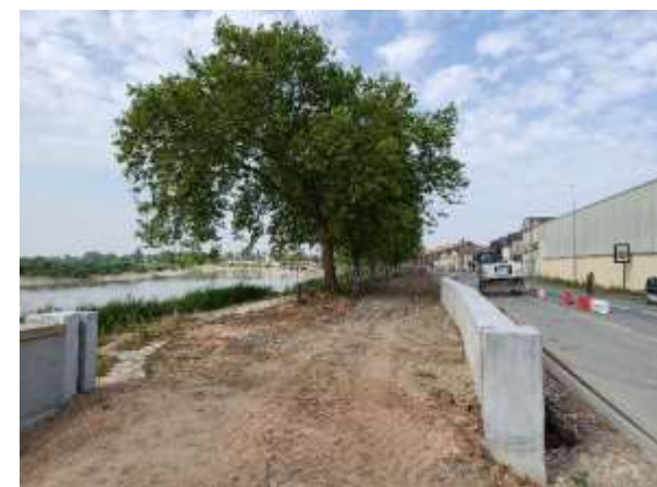
Travaux avenue de la Libération
