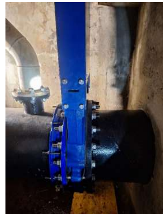
Remplacement de la vanne opercule
