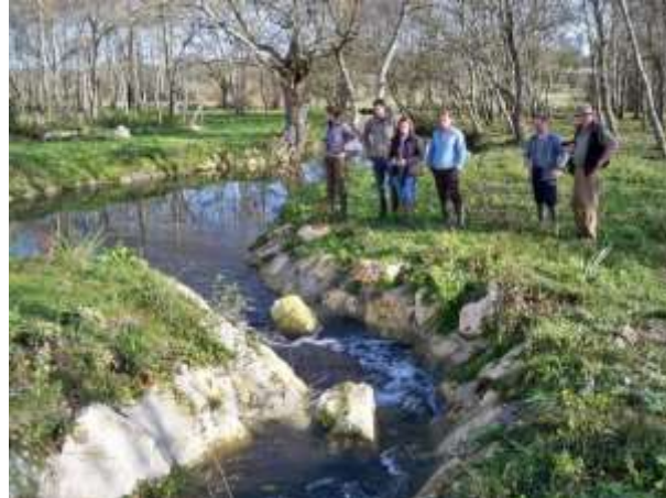
Conseils et suivi de chantier
