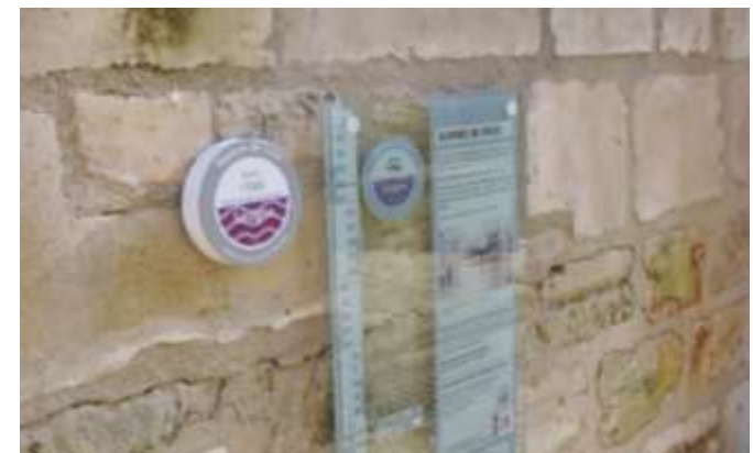
Repère et plaque posés 2 rue de la gare à Pons
