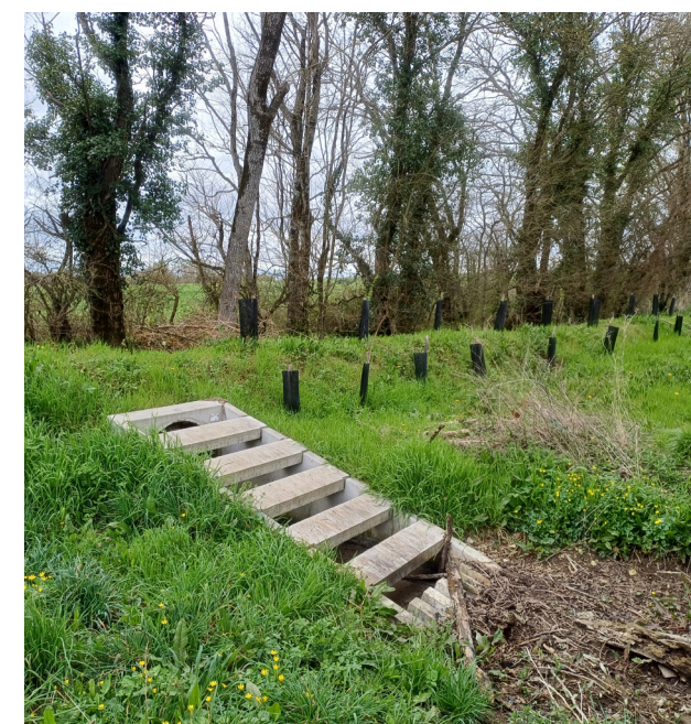
Plantation de haies sur talus avec déversoir pour limiter le ruissellement sur la commune de Seigné (17) par le SYMBA
