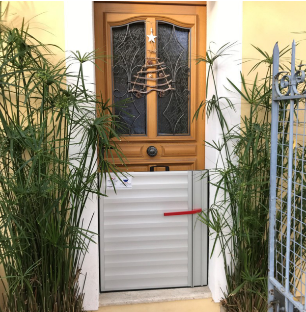
Exemples de mesures de mitigation de la vulnérabilité d'un bien (batardeaux, mise en place de volets faisant office deatardeaux) (©Mayane)
