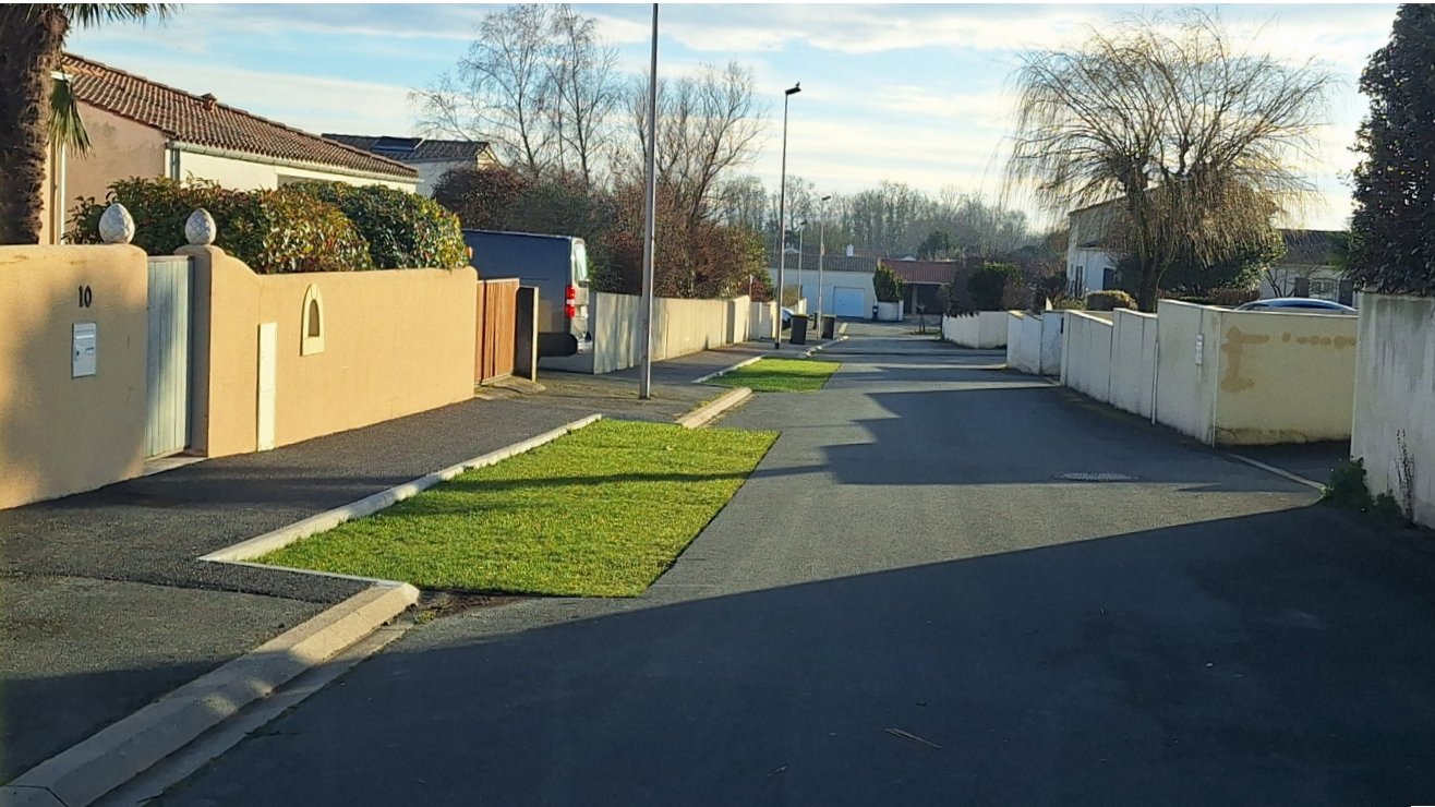
Aménagement de la voirie à Salles-sur-Mer (©Agglomération de la Rochelle)
