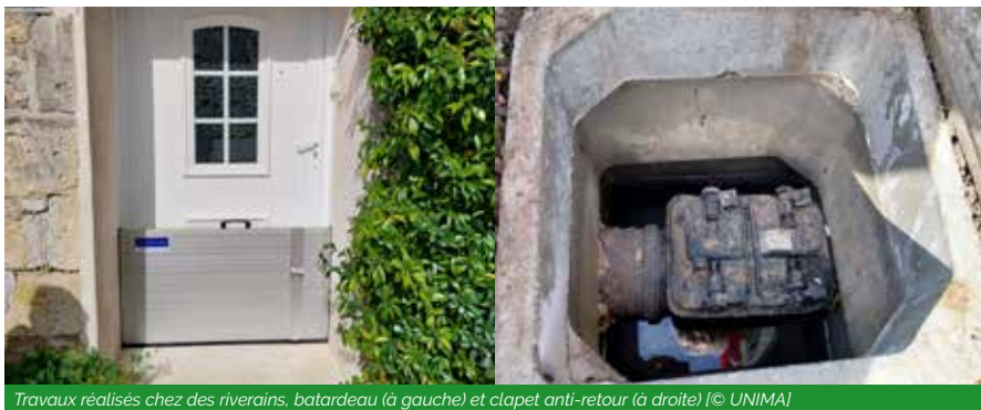
Travaux réalisés chez des riverains, batardeau (à gauche) et clapet anti-retour (à droite) [© UNIMA]
