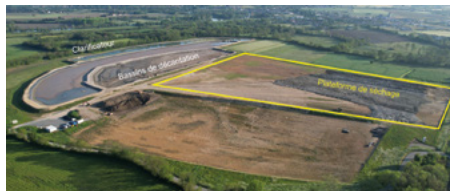
Vue aérienne de la plateforme de séchage des sédiments © Département de la Charente-Maritime
