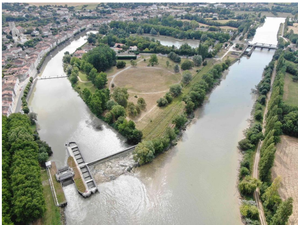
Figure 4 : Vue aérienne des ouvrages hydrauliques de Saint-Savinien (Damien Filloux, MIGADO)
