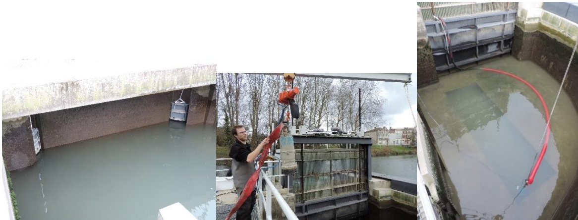
Figure 37 : Illustrations du test de la mise en place de batardeaux en 2022
