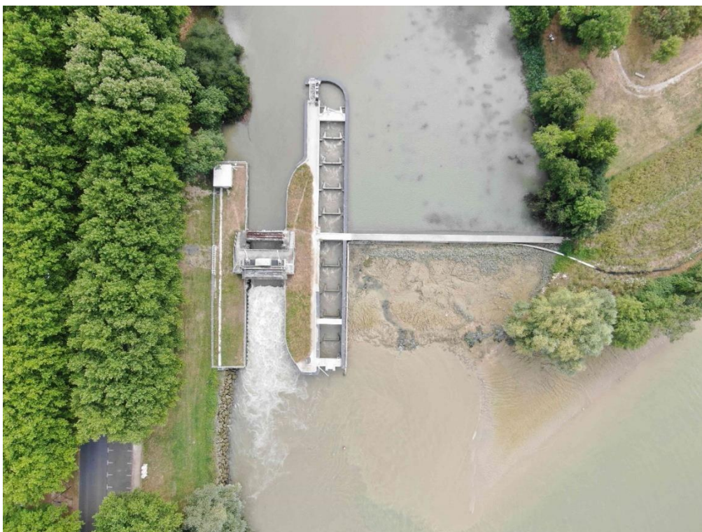
Figure 6 : Vue aérienne des ouvrages installés sur le bras naturel (Damien Filloux, MIGADO)
