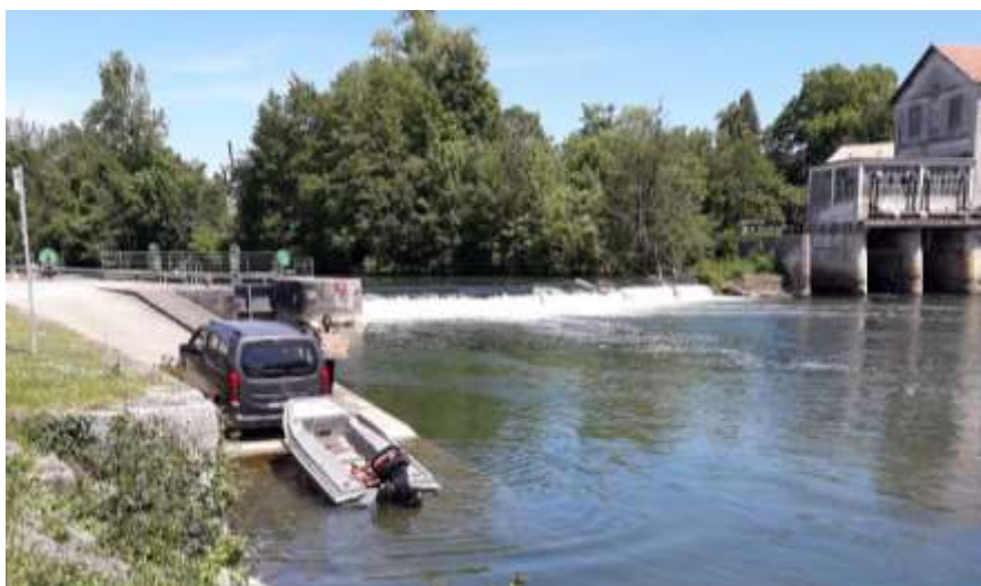
Cale de mise à l'eau à Basseau en RD en aval du barrage
