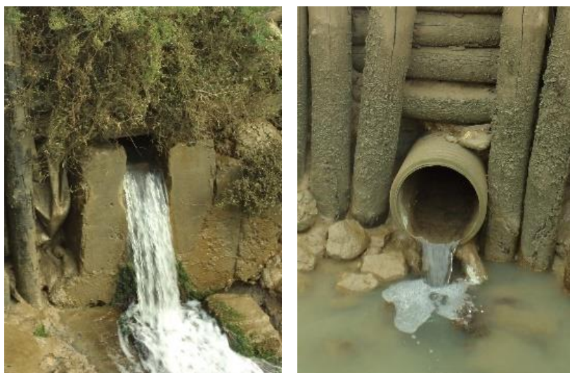
Figure 4 : Ouvrages de type 2 (gauche) et de type 3 (droite) © CAPENA
