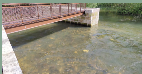
Passerelle installée à Saint-Simon au-dessus du radier construit suite à la déconstruction d'anciens passages d'eau (14/04/2022).
