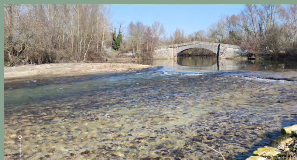
Radier amont de Vibrac (09/02/2023).
