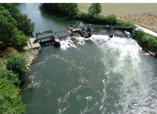
Barrage de Crouin vu par drone (19/05/2022).
