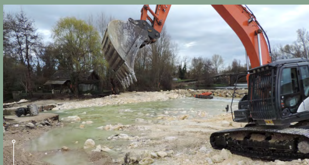
Construction du radier amont de Vibrac (11/03/2022).
