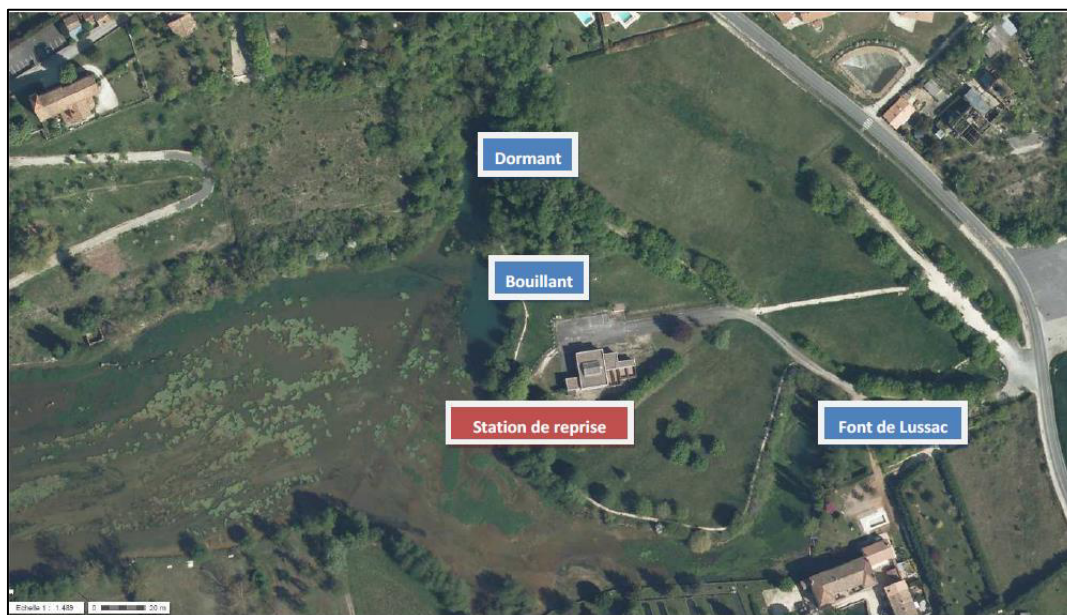
Figure 8: Vue aérienne des sources de la Touvre ainsi que de la Station de reprise (Source: Géoportail)
