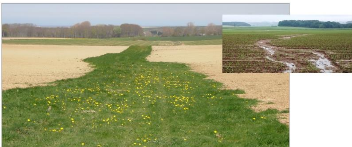
Figure 60 : Chenal enherbé implanté dans l'axe du ruissellement concentré (encart : situation initiale) (Source : LIOSE)
