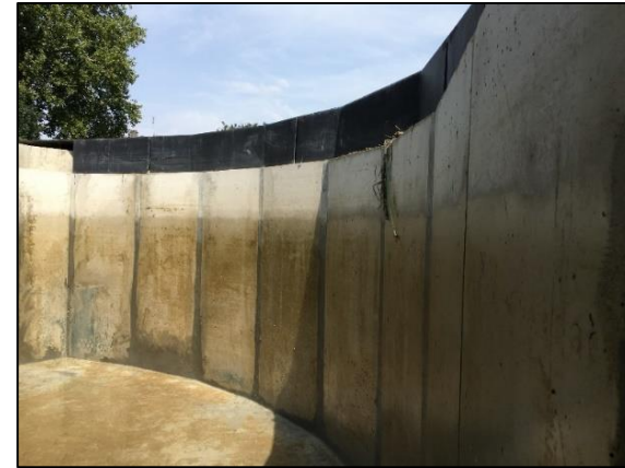
✓ Coffrage du bassin
