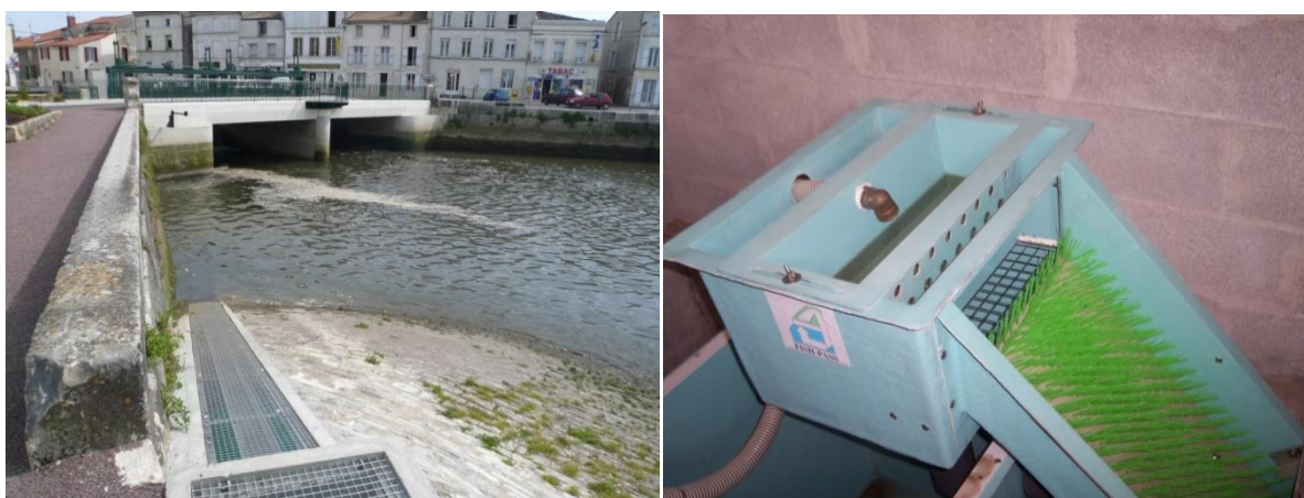
Figure 33: Photos de la passe piège anguilles de Saujon (brosse extérieure sous grille et piège)
