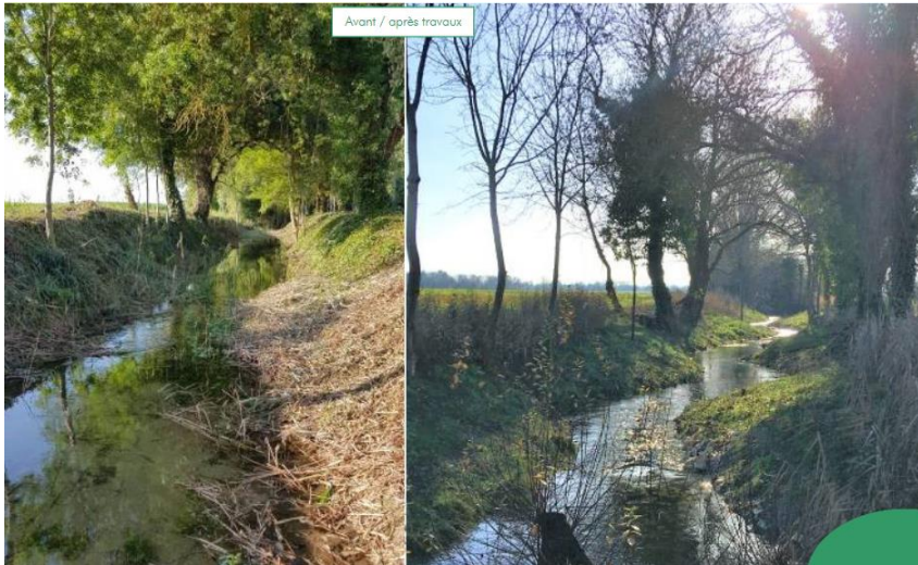
La Divise avant/après travaux
