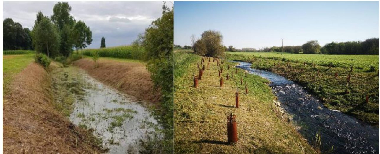
Le Siarne avant/après travaux
