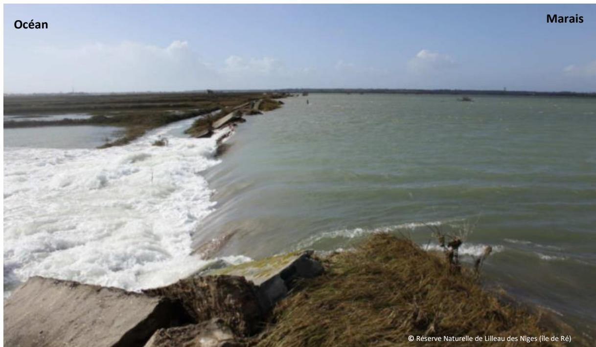
**Figure 31** | exemple d'une vidange de submersion marine à marée basse
