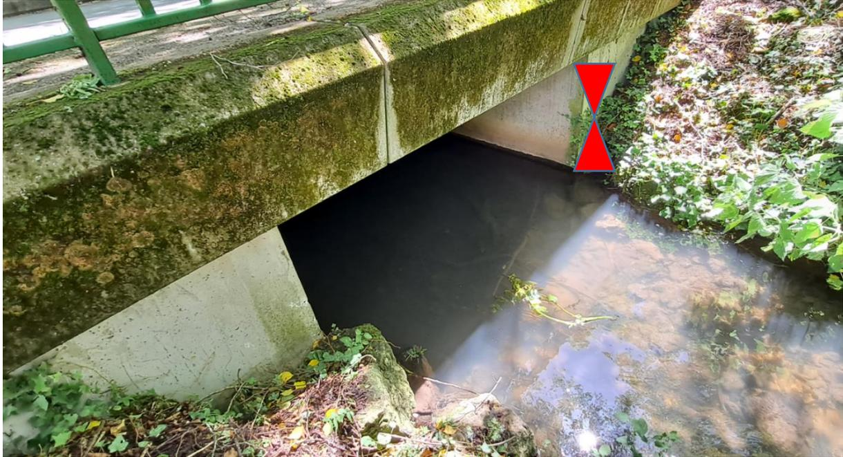
Proposition en rive gauche et en aval car installation abritée des écoulements de crue.
