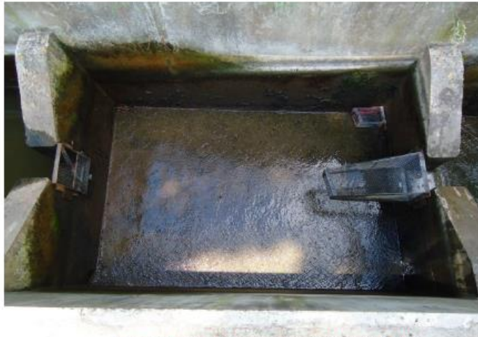
Figure 13 : Le piège de la passe à poissons du moulin de Béli.
