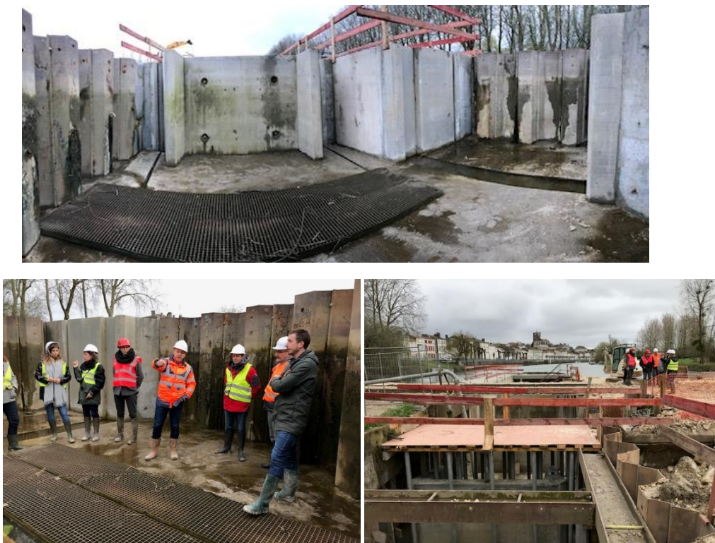
Figure 52: Photos du chantier 15 mars 2019
