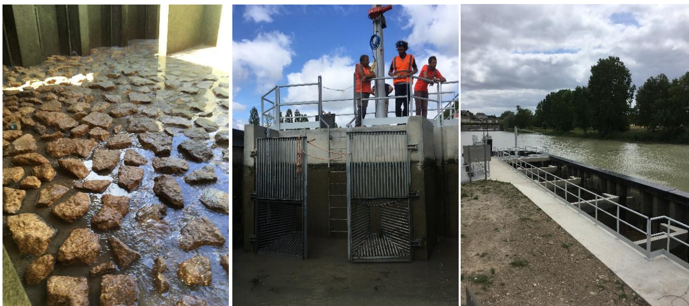
Figure 54: Photos fin de chantier le 18 juillet 2019
