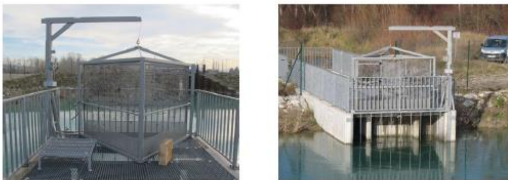
Figure 5 : Second piège (cage triangulaire) utilisé sur la passe à poissons de Livron. CNR
