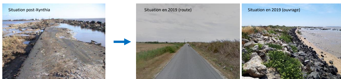
Figure 57 | dégâts sur la route et l'enrochement de Font Renaud après Xynthia (2010)
