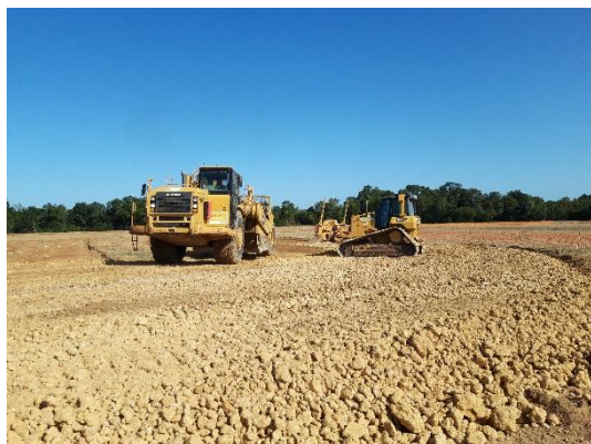
FIGURE 73 : TERRASSEMENT DES DIGUES DES LAGUNES DE DECANTATION - AOUT 2019
