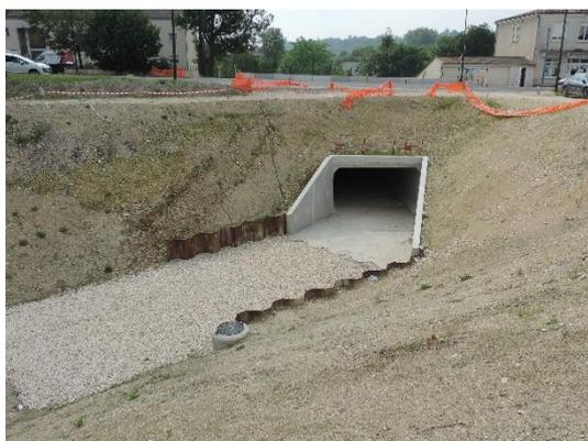
FIGURE 76 : OUVRAGE DE DECHARGE DE L'ANGUIENNE A ANGOULEME
