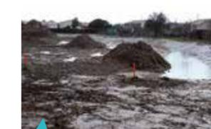
**CARO** : Travaux pour le ressuyage hydraulique à Port-des-Barques (17) - zone tampon de captation des eaux de franchissement des digues.
