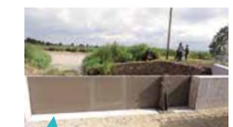
**CARO** : dispositif de protection amovible contre les submersions marines installé au Martrou à Echillais (17) au droit d'une cale de mise à l'eau.
