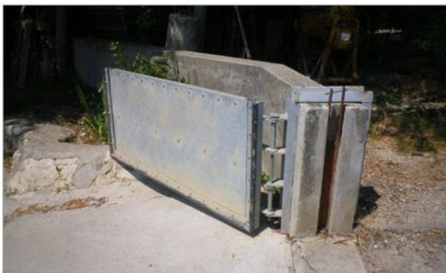
Fig. 68. Vue du principe de batardeau mobile sur muret béton
