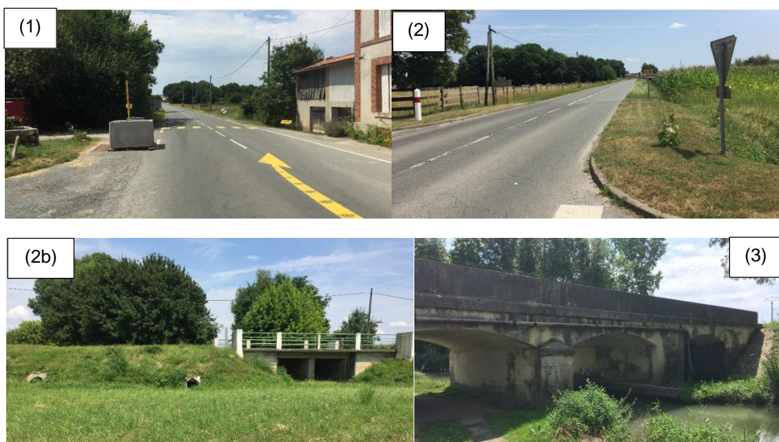
Fig. 27. Photographies prises le long de la RD18 (2b : deux buses et pont avec 2 cadres ; 3 : pont avec 3 arches)
