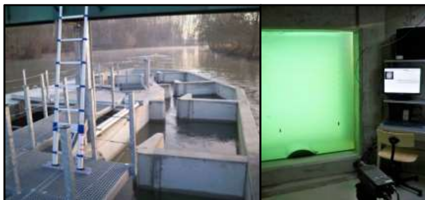
Figure 7 : Photos de la passe à bassin et du local de comptage de Crouin (Source : F. ALBERT)
