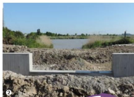
prolongement à l'ouest du muret de la cale, le rechargement à niveau du chemin en rive, le soutènement ainsi que la protection contre l'érosion du tronçon de berge actuellement sujet à affaissement.
