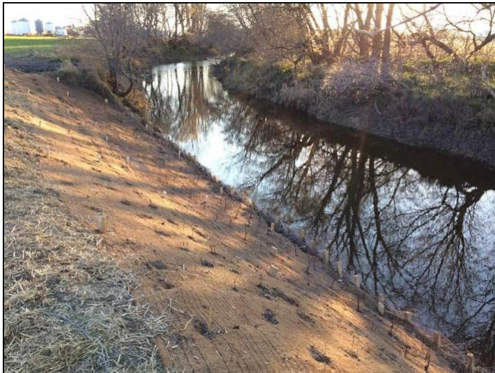
FIGURE 3 : STABILISATION DE BERGE – TRESSAGE, POSE DE TOILES ANTI-ÉROSION ET REVÉGÉTALISATION DANS LE BV L'ACADIE
