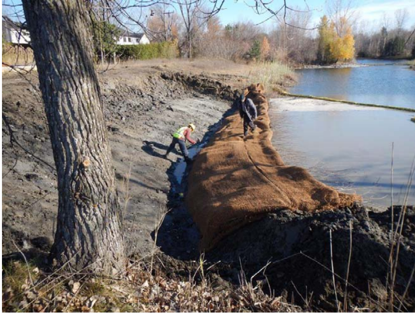
FIGURE 2 : LUTTE AU ROSEAU COMMUN – MÉTHODE MÉCANIQUE PAR EXCAVATION DE SOL CONTAMINÉ
