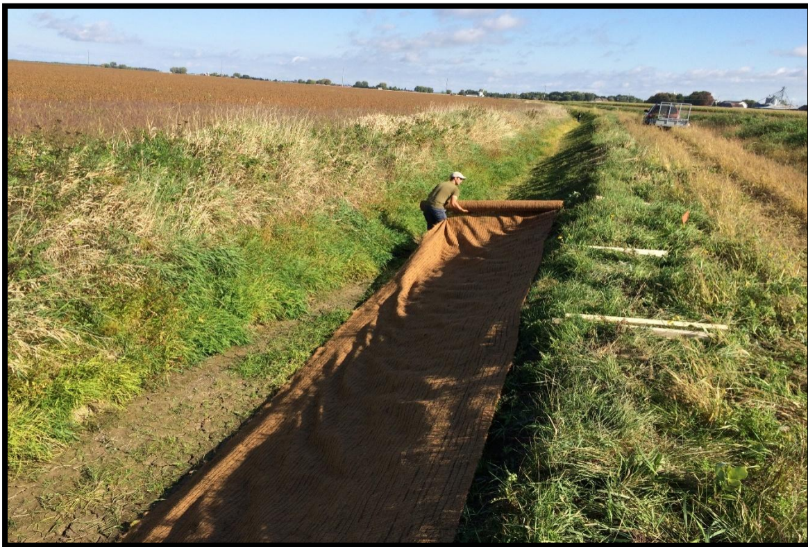
FIGURE 4 : STABILISATION DE BERGE À L'AIDE DE TOILES ANTI-ÉROSIVES - RIVIÈRE DU SUD
