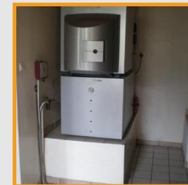
Chaudière mise hors d'eau par surélévation
