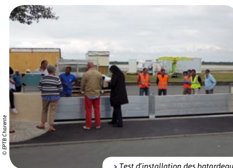
> Test d'installation des batardeaux
