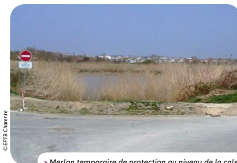
> Merlon temporaire de protection au niveau de la cale
