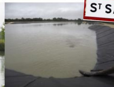
Refolement de la mixture dans un des bassins de décantation ©EPTB Charente
