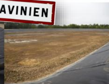
Séchage des sédiments dans un des bassins de décantation ©EPTB Charente
