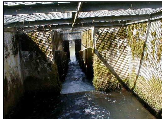
**3 passes à ralentisseurs plans** (salmonidés) mises en place sur les bras de décharge amont du système hydraulique du moulin. Ces passes sont jumelées à des clapets.
