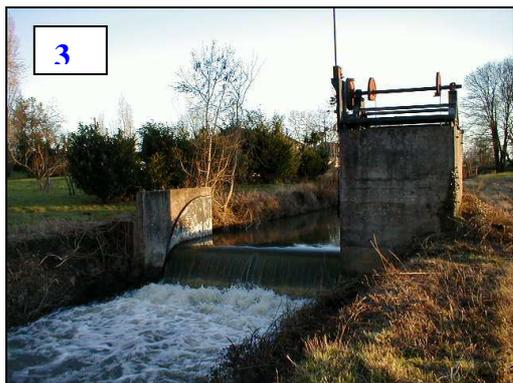
1- 2 vannes verticales de gestion hydraulique au niveau des Tanches. La vitesse d'écoulement produite par l'étranglement ne permet pas la remontée de l'Anguille.
