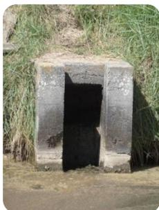
Photographie d'un moine en béton côté fossé et d'une déraser en bois, glissée dans les feuillures du moine et permettant de maintenir un niveau d'eau adéquat dans le fossé.
