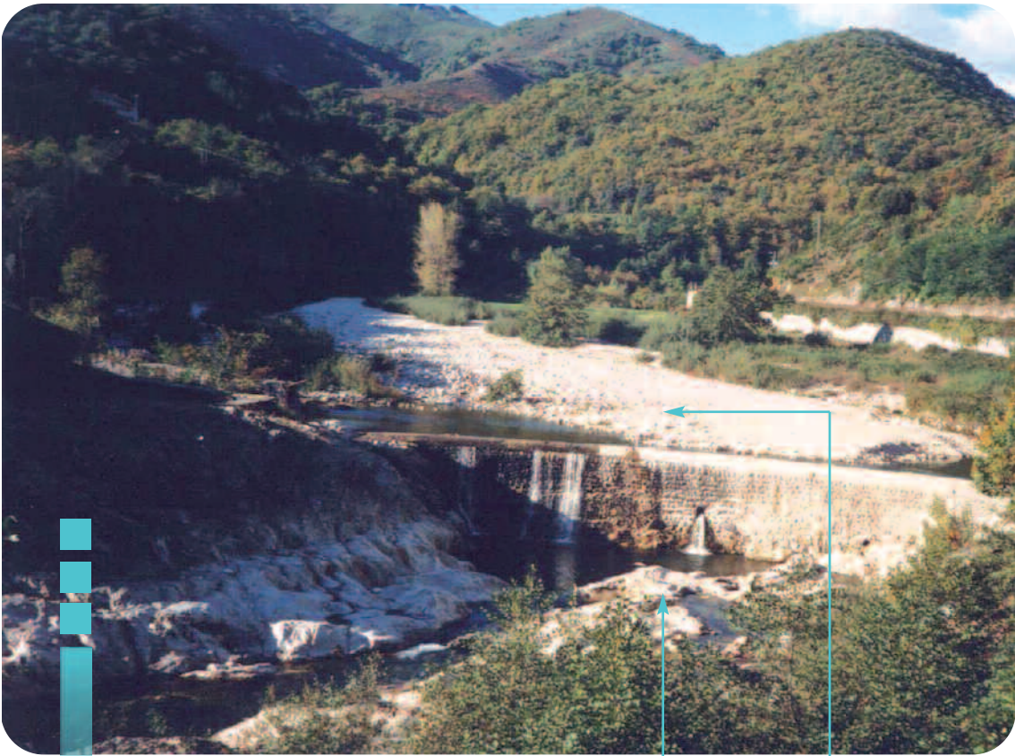
Les sédiments du cours d'eau (l'Ardèche) sont piégés en amont du seuil
