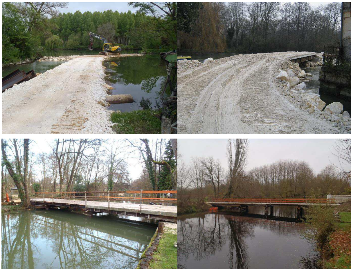
Photo 14 : Exemple de passages à gué et/ou pont provisoire
