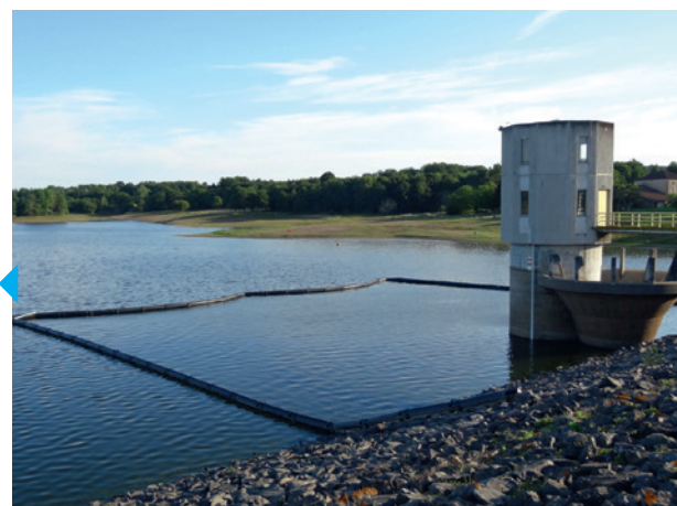
Remplacement de la Drome et renforcement des ancrages
