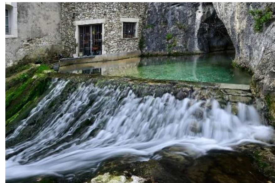
Exemple le plus probant : barrage de Dardennes alimentant la ville de Toulon
