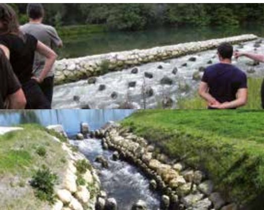
Passe à poissons de Bourg-Charente sur la Charente Passe à poissons de l'Houmée sur la Boutonne
