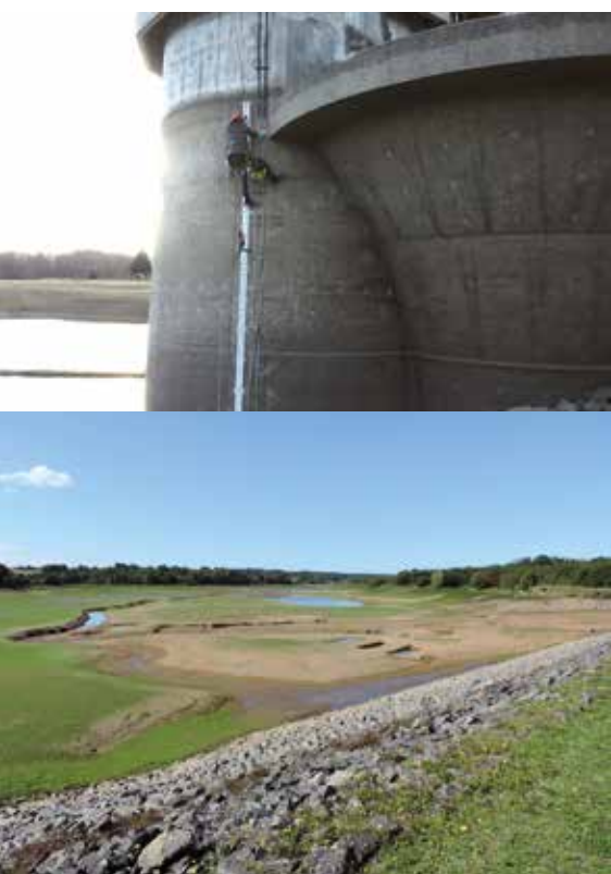
Mise en place de l'échelle limnimétrique Vidange de la Guerlie
