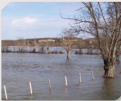
Port d'Envaux - La Charente est sortie de son lit ; la plaine constitue ici un important champ d'expansion des crues © EPFB Charente - 17/03/2006
