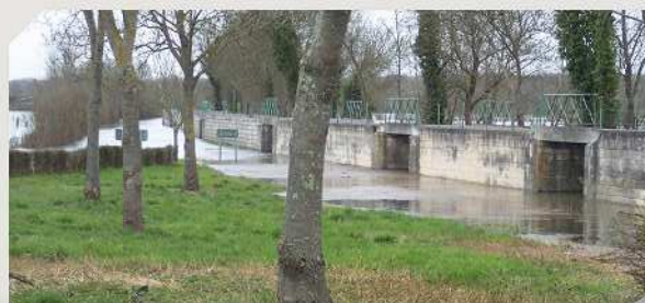
Port-d'Envaux - La chaussée Saint-James provoquerait une sur-inondation se faisant sentir jusqu'à Saintes. © EPB
