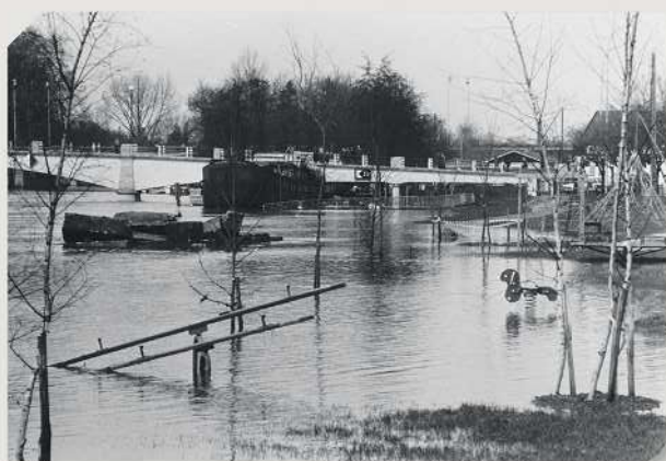
Angoulême - Boulevard Besson Bey / Passerelle de Bourgines © Jean-Pierre Guillaume - Archives Ville d'Angoulême
