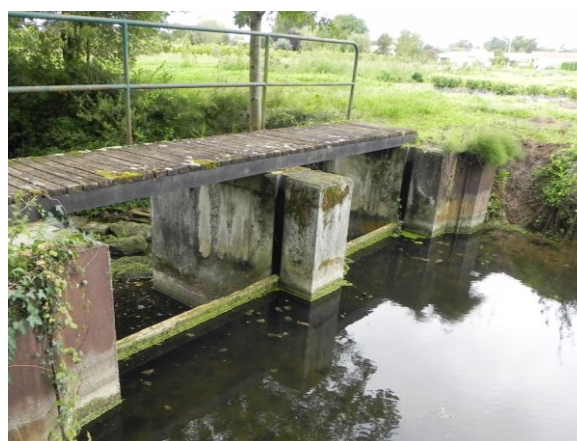
Seuils à madriers sur cours d'eau
