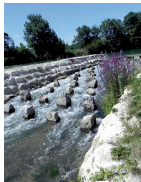
Passe en enrochements de Gondeville (Charente)
