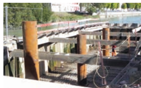
Travaux de la passe multi-espèces de Saint-Savinien
