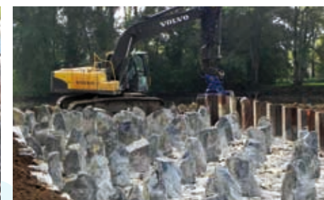
Travaux de la passe en enrochements de Saintonge
