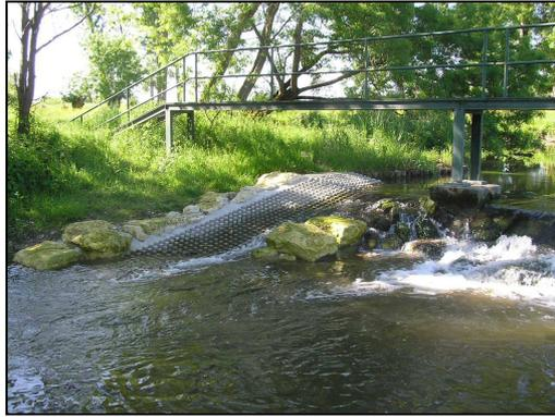
**Figure 57 : Passe spécifique anguille avec substrat plots sur la Seugne (F. ALBERT)**
