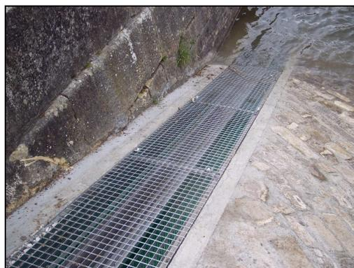
Figure 28 : Passe extérieure avec substrat de reptation pour l'anguille (F. ALBERT)
