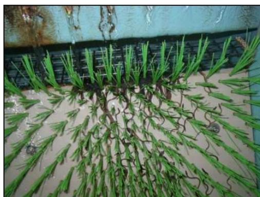
Figure 29 : Piège en amont de la passe avec anguillettes présentes sur le tapis brosse (A. POSTIC-PUIVIF)
