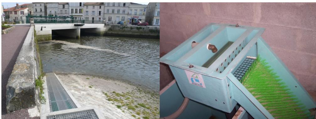
Figure 34 : Photos de la passe piège anguilles de Saujon (brosse extérieure et piège)
