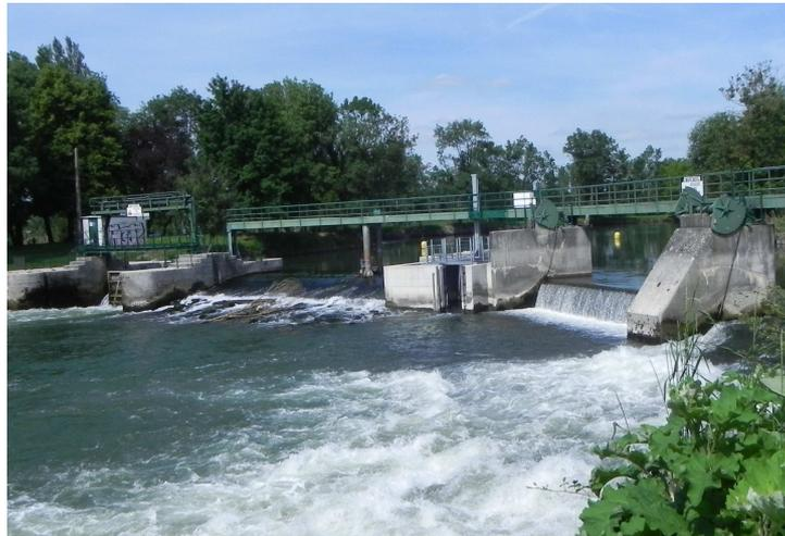
Figure 48 : Barrage de Crouin et passe à poisson avec station de comptage (31/05/12)
