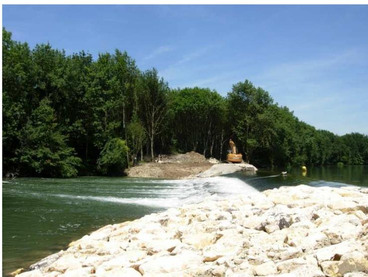
Figure 5 : Travaux sur la Charente en 2012 : passe à poissons de Solençon
