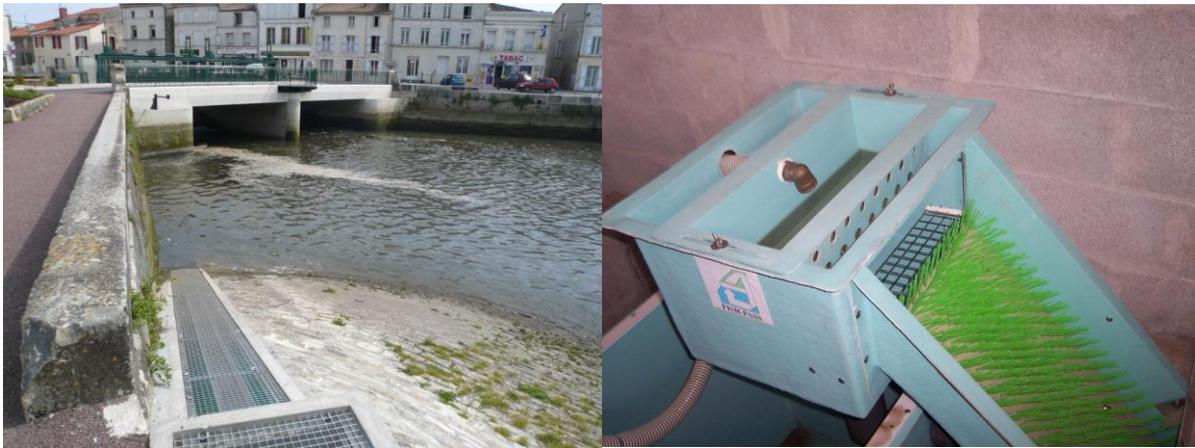
Figure 36 : Photos de la passe piège anguilles de Saujon (brosse extérieure et piège)
