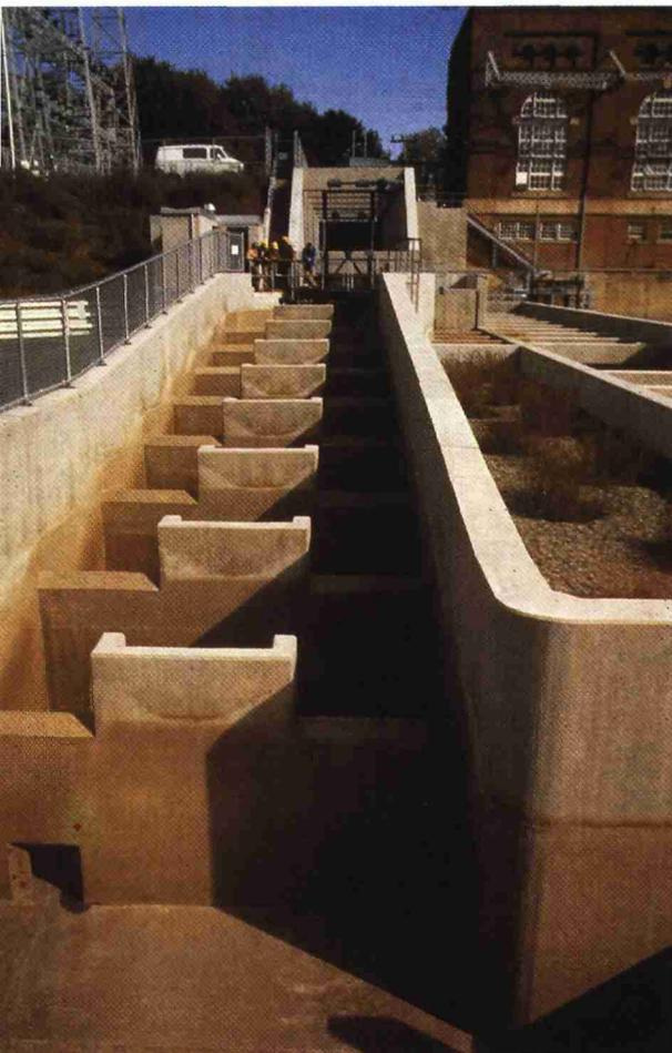
Passe de type Ice Harbor au barrage de Vernon (rivière Connecticut, USA)
