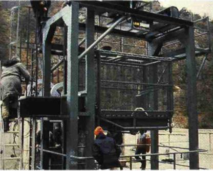
Cuve en position haute, dispositif de levage de l'ascenseur de Poutès sur l'Allier (Haute-Loire)
