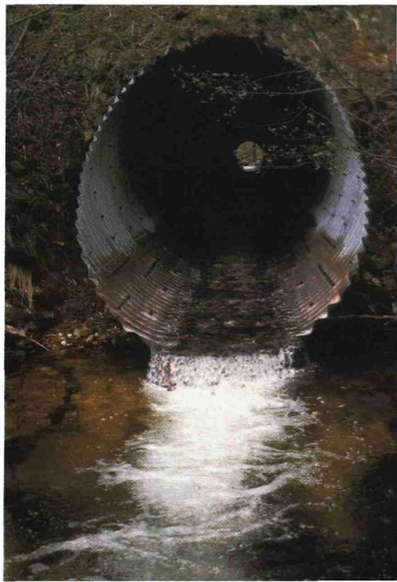
Ils peuvent constituer des obstacles sérieux à la migration des poissons : vitesses trop fortes à l'intérieur de l'ouvrage (pouvant atteindre de 3 m/s à 4 m/s), tirants d'eau insuffisants, chutes importantes à l'extrémité aval, enfin accumulation de débris représentent les causes de blocage des migrateurs les plus fréquentes.
