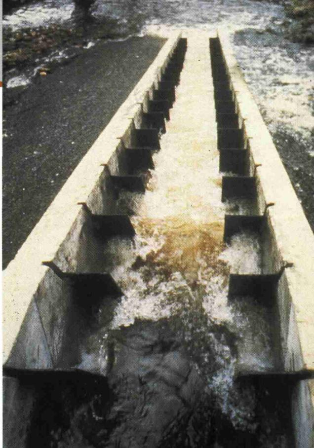
L’écluse à poissons (ou écluse “Borland”) fonctionne suivant un principe voisin de celui d’une écluse de navigation : les migrateurs sont piégés dans un sas puis éclusés comme le serait un bateau.
