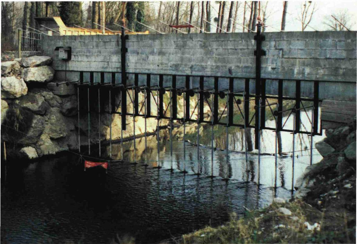
Ecran électrique de remontée installé à la sortie d'un canal de fuite d'une microcentrale à Auterive - Gave d'Oloron (64).
