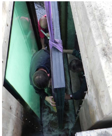
Vitre neuve tri-feuilletée (6 cm d'épaisseur totale)
