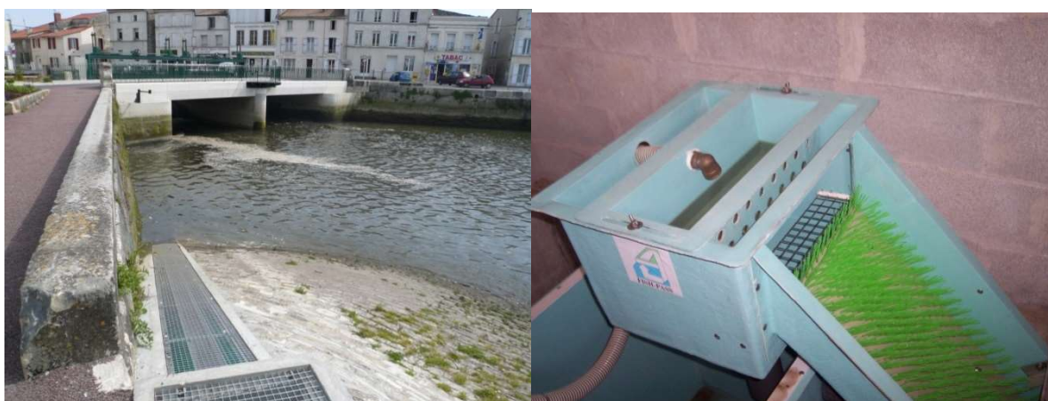
Figure 34 : Photos de la passe piège anguilles de Saujon (brosse extérieure sous grille et piège)
