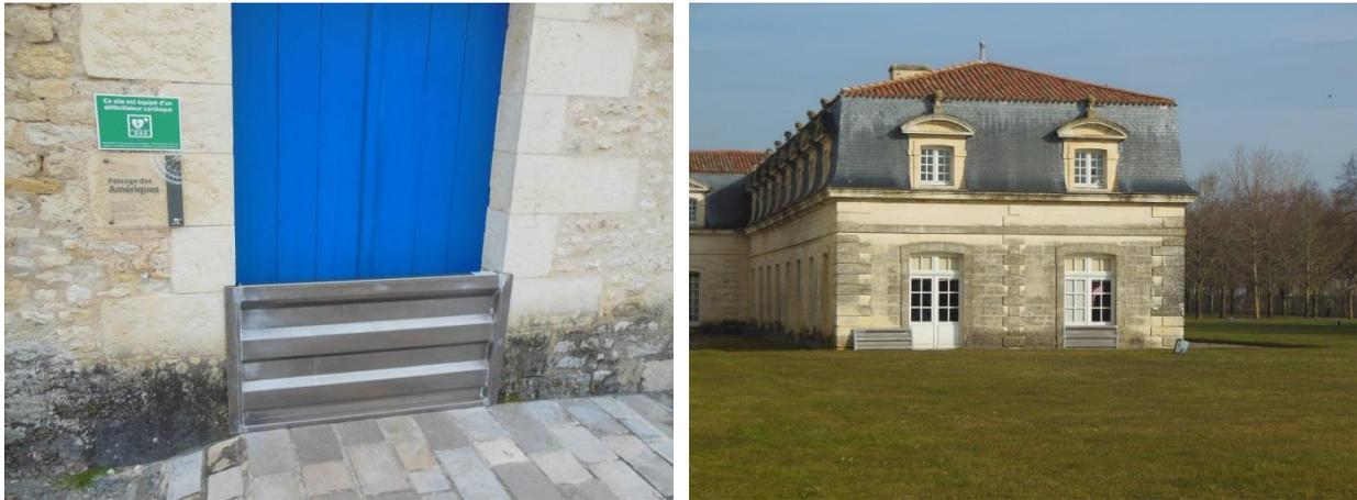
Figure 32 : photographies des batardeaux en aluminium équipant la Cordierie Royale
