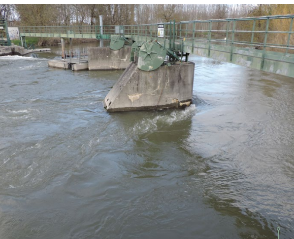
Barrage de Crouin avec un débit de 135 m 3 /s (24/03/2023)
