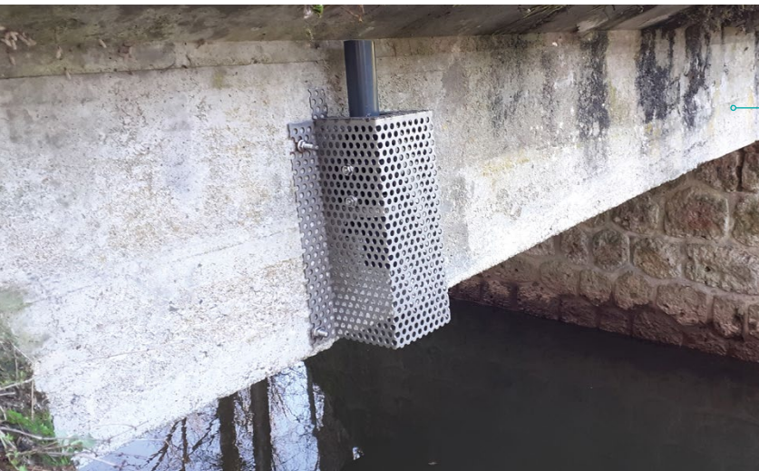
Sonde radar installée et sécurisée sur la Charente (Videix)
