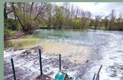
Antenne posée sur le barrage de Bourg-Charente
