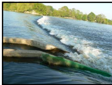
Passe à ralentisseurs équipée d'un substrat anguille sur la Mayenne
