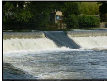
Echancrure dans un seuil de faible hauteur
