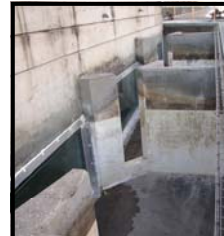
Vitres de comptage vues de l'extérieur
