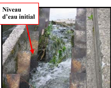
Passe à ralentisseurs plans colmatée
