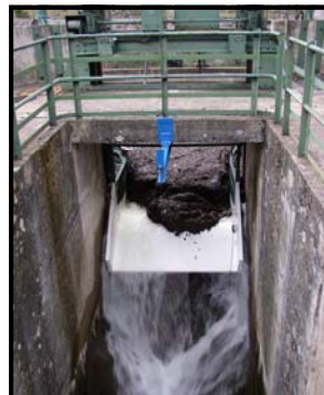
Passe colmatée par un bloc de feuilles en décomposition
