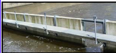
Passerelles permettant d'accéder à la sortie de la passe
